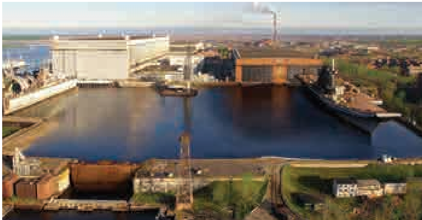
АО «Производственное объединение «Севмаш», г. Северодвинск
