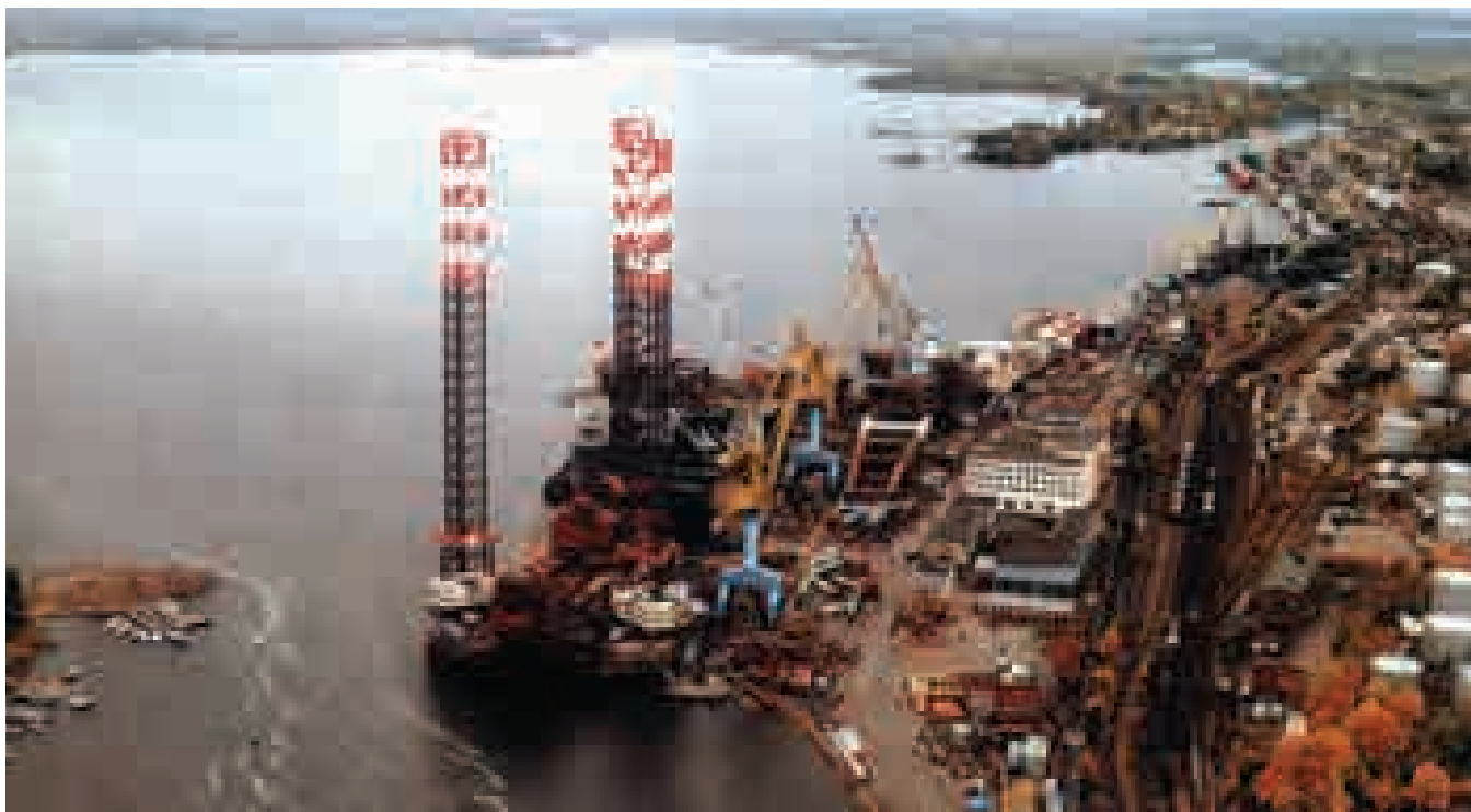
Достроечная набережная для буровых платформ, Выборгский судостроительный завод
